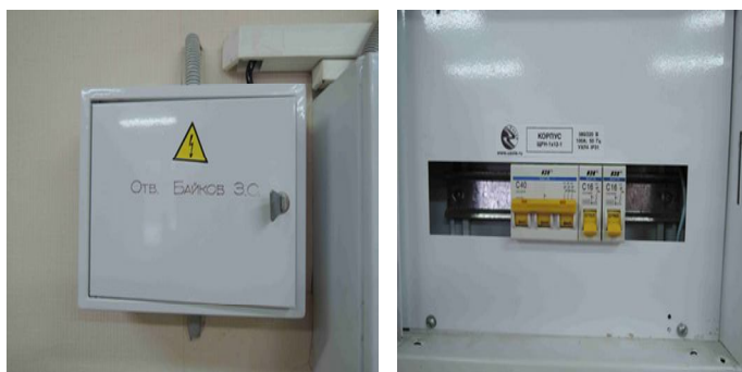
Рис.44. Общий вид электрического щита
