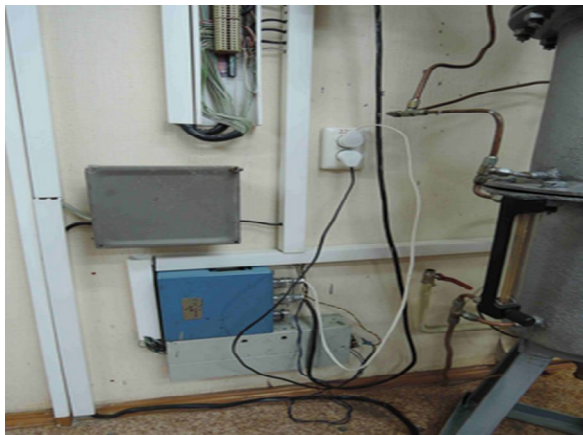
Рис.42. Модуль расходомера – синяя коробка, блок управления клапанами ниже
