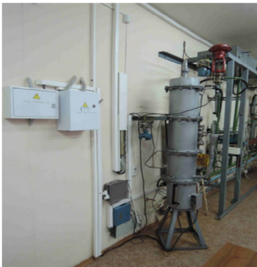
Рис.43. Общий вид ректификационной колонны
