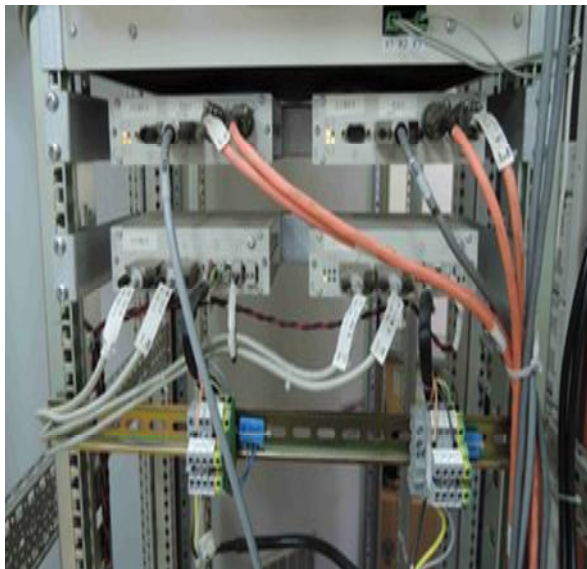
Рис.34. Блоки связи для подключения операторной и инженерной станций
