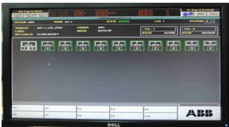
Рис.46д. Просмотр рабочих параметров входов/выходов ректификационной установки
