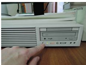
Рис.37. Загружается инженерная станция
